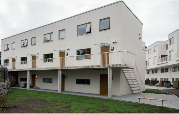
Nordfasade på Bygg C.
