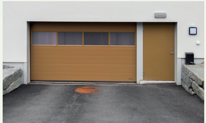
Garasjeport på Bygg B.
