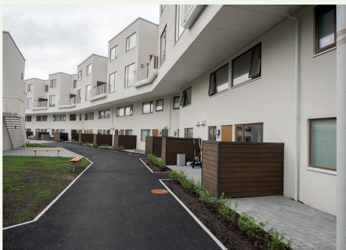
Bygg B har to slake vinkler, som gir bygget en buet form.
