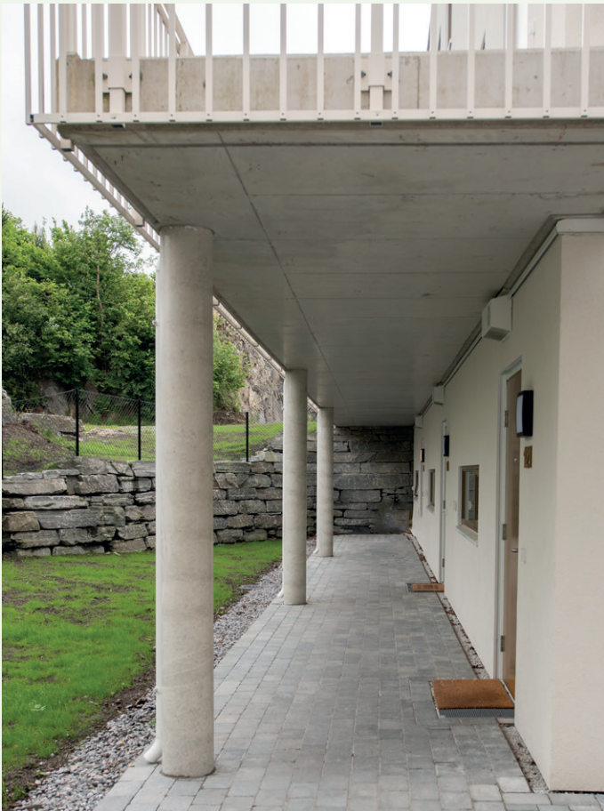
Søylegang på nordsiden av Bygg C.
