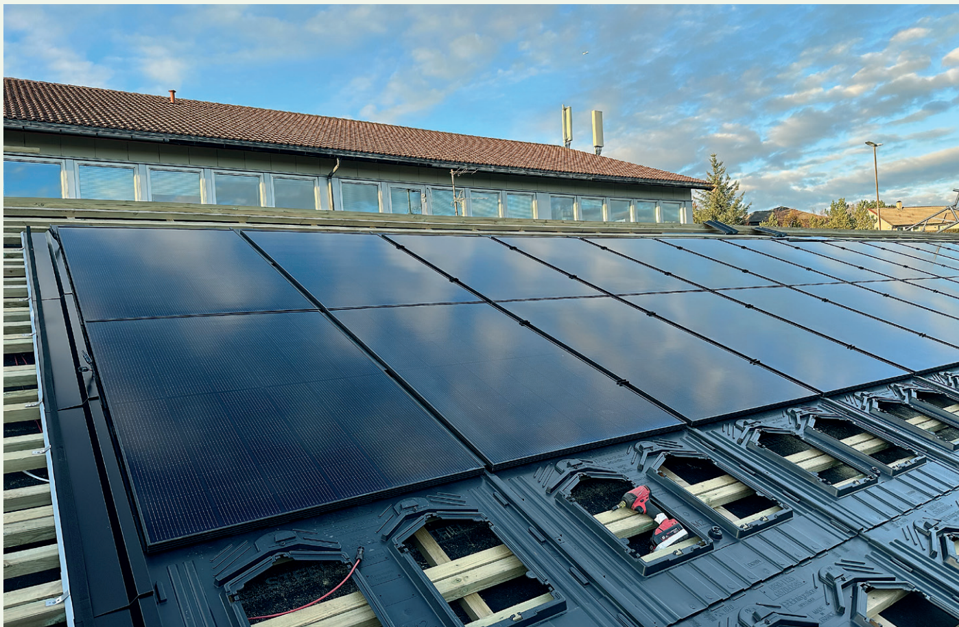
De skrånende delene av taket får solcellepaneler.
