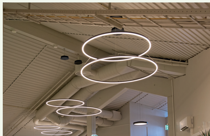
Taklys ved hovedinngang.
