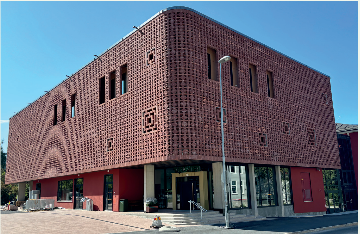
Langveggen på tilbygget retter seg mot NTNUs hovedbygning på Gløshaugen. Bygget har fått en karakteristisk teglfasade.
