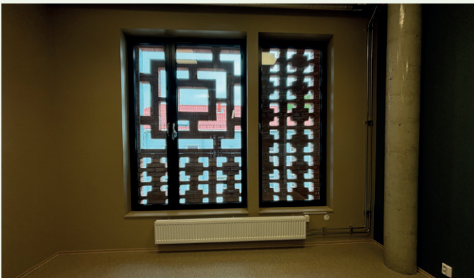
Slik ser det ut innenfra med den påhengte teglfasaden på utsiden.
