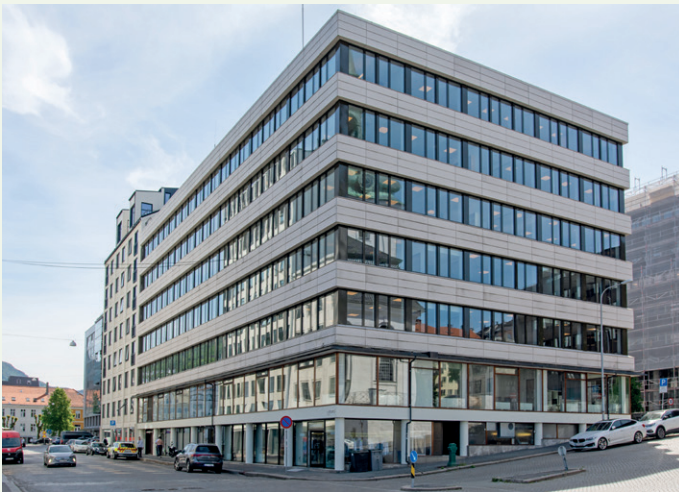
På åtte måneder har LAB Entreprenør totalrenovert og bygget om 5.500 kvadratmeter i Strandgaten 197.
