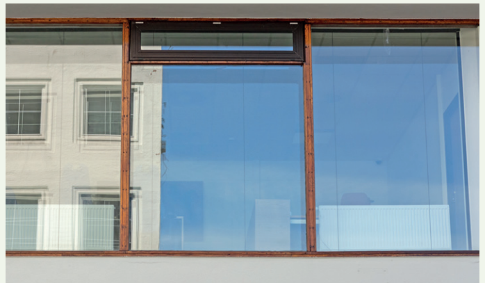
Mot C. Sundts gate er en del vinduer med særpregete vindusrammer beholdt. Det er satt opp nye vinduer innenfor de eksisterende slik at strenge lydkrav oppfylles.
