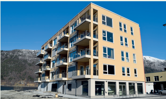
Bygget sett fra sør-vest.
