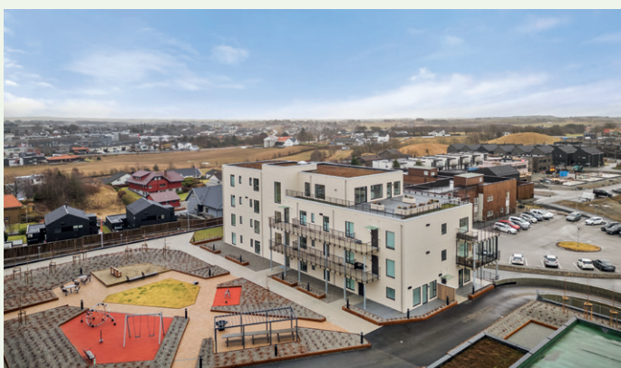
Blokkene ligger på en høyde, i tilknytning til nye og etablerte boliger. Foto: Masiv
