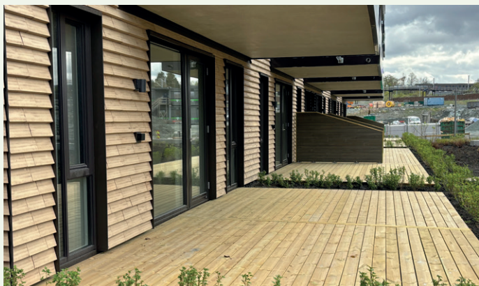
Første etasje har terrasser på bakken
