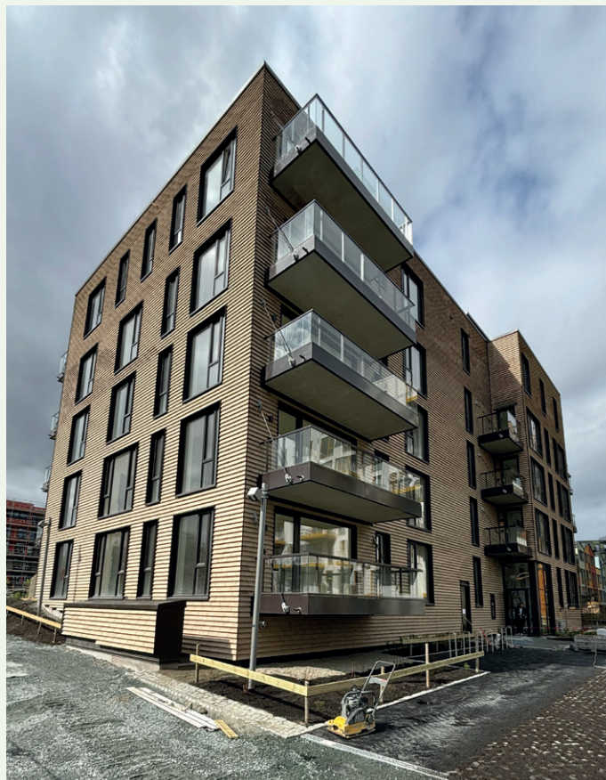
Fasaden er kledd med lys gul beklædnings-tegl.
