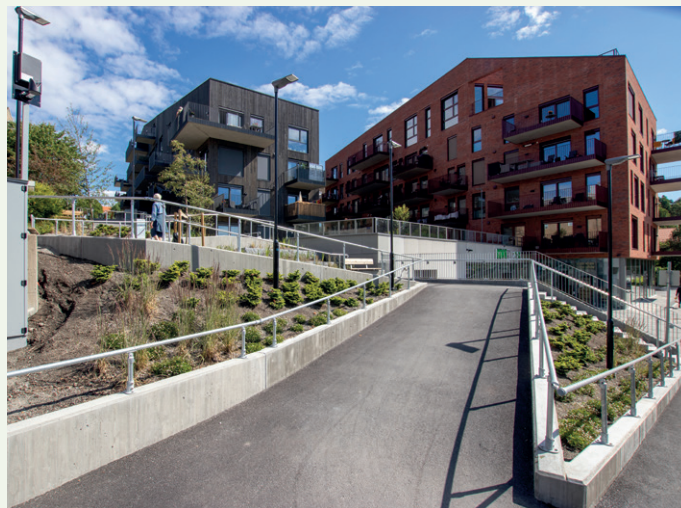
En sikk-sakk-gangvei med trapper ved siden av gjør det enkelt for alle å ta seg ned fra boligene til gateplan.
