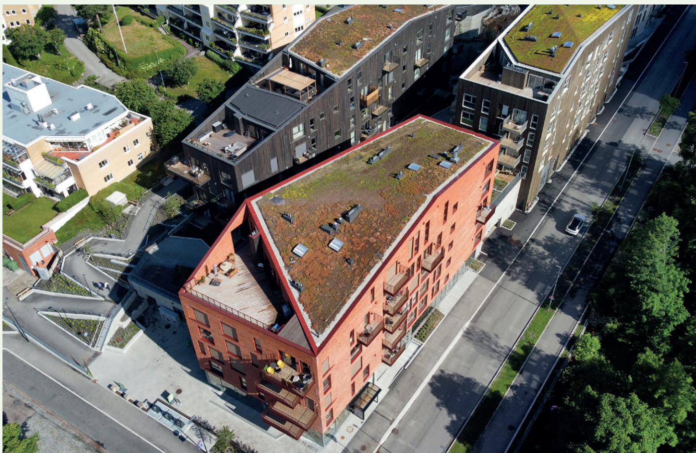
Man har fått plass til både takterrasser og grønne tak.
