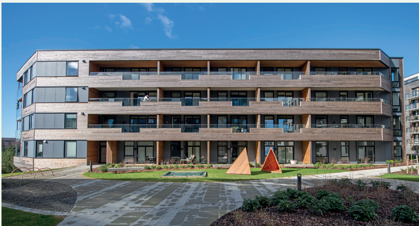
Sørfasade på tverrbygg.
