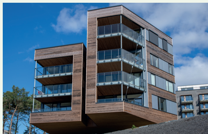
Fasade mot vest på tverrbygg.
