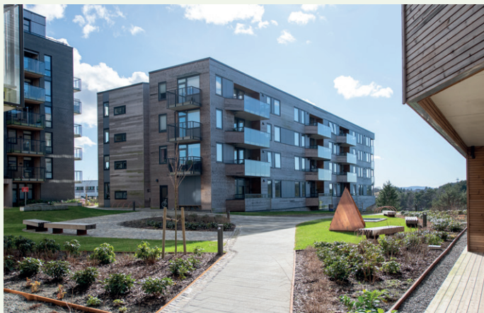
Sandsli 360 består av seks bygg med pent opparbeidete uteområder mellom byggene.
