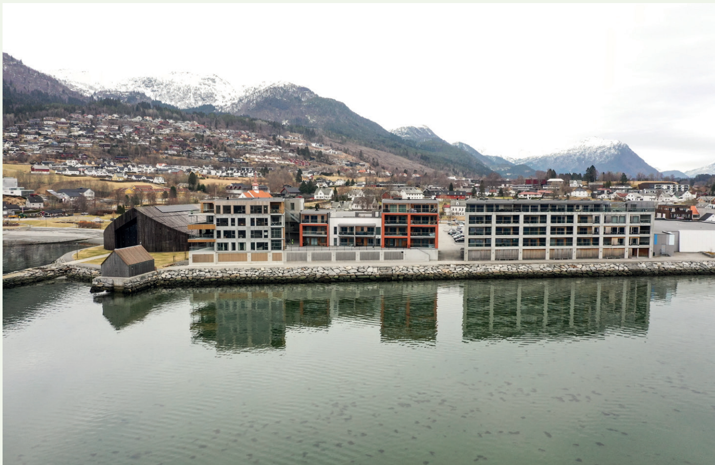
Sagaparken Panorama sett i droneperspektiv fra sjøsiden. Boligprosjektet er bygget mellom kjøpesenteret Alti på 11.500 kvadratmeter og sjøen. Bygg A til høyre henger fysisk sammen med kjøpesenteret, og du kan gå tørrskodd fra boligdelen inn i kjøpesenteret.
