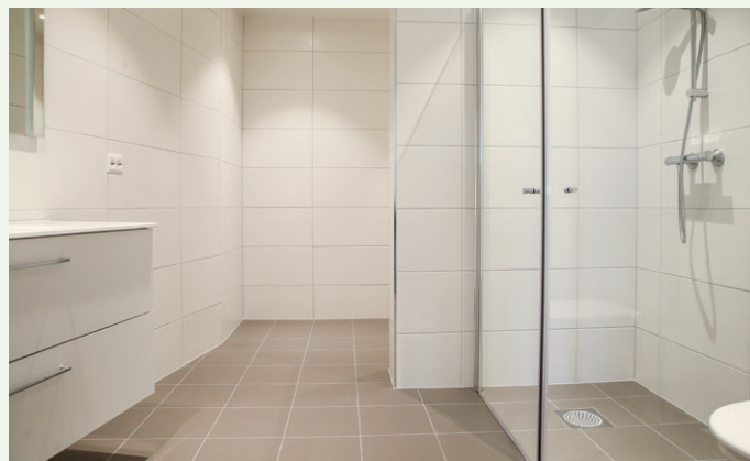
Badene er bygget på stedet. Vegger og gulv er flislagt av Maler Rune Skilbrei.
