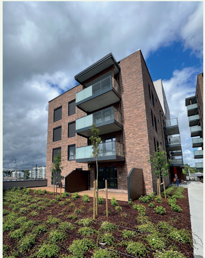
Utbyggingen av trinn 4 har skjedd i en totalentreprise, og kontrakten har en verdi på 425 millioner kroner, eksklusive merverdiavgift.
