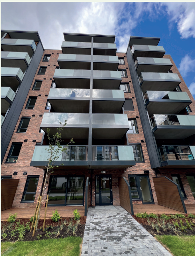
De siste leilighetene i Saga Terrasse byggetrinn 4 er nå overlevert.
