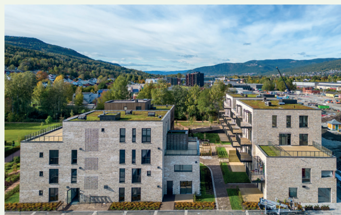
Byggene er i hovedsak teglsteinforblendet. Et av leilighetsbyggene har trefasade.
