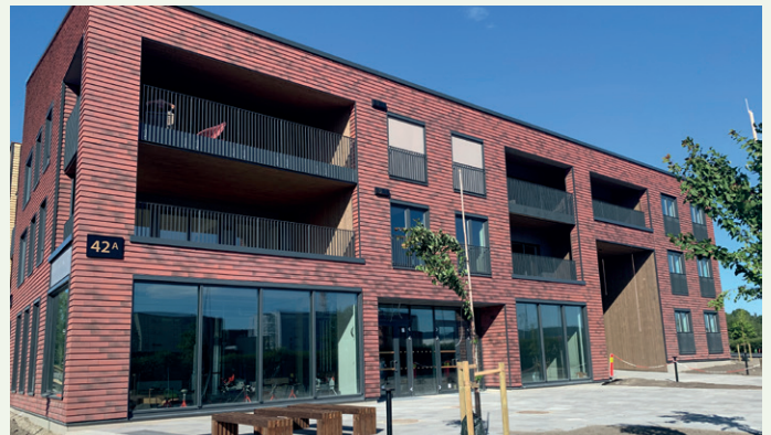
Fasaden ut mot Østmarkveien har skjermetegl.
