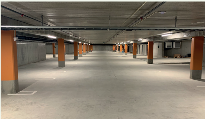
Parkeringskjelleren har plass til cirka 60 biler. Det bygges i alt rundt 200 boliger.
