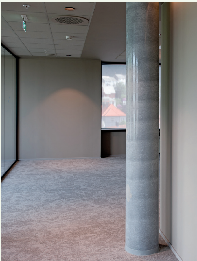
Betongsøyle i sjette etasje.
