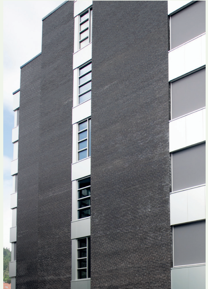
Tegl på fasade mot nord.
