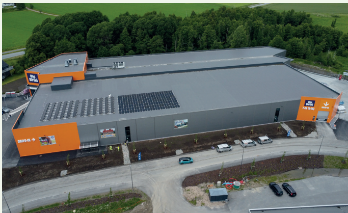
Det er montert solceller på deler av taket.
