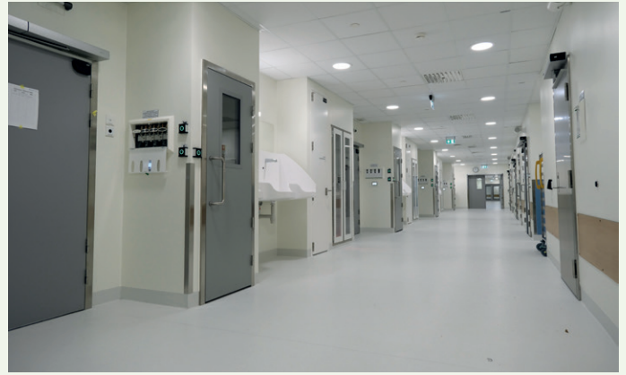
Det nye sykehusbygget har et bruttoreal på 45.000 kvadratmeter.
