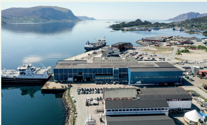
Bygget sett fra øst med nybygget nærmest til høyre og et mindre tilbygg til venstre. Notlageret ligger bak mot kaia.
