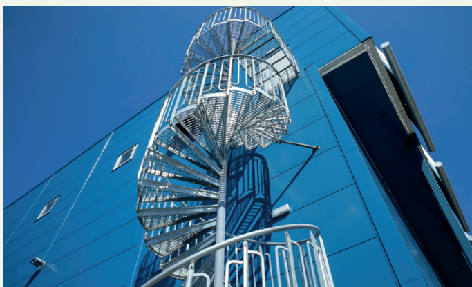
Varhaug Bygg & Montasje har levert stål og sandwichelementer til utbyggingen. Her ser vi fasade og rømningsvei til det nye notlageret.
