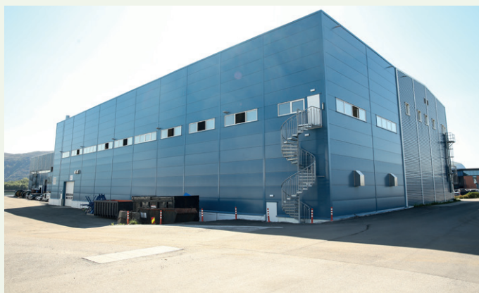
Det toetasjers nybygget med grunnflate på 900 kvadratmeter er det største av nybyggene på Egersund Herøy. Her sett fra nordøst.
