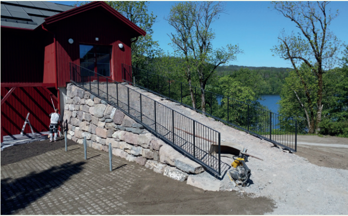
Gjenbruk av natursteinsmur, teglmurer og kledning bidrar til å gjenskape uttrykket til «gjødselkjeller, teglmur og høylåve».
