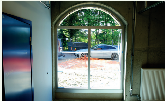
Betongen rundt det buede vinduet er ekstrem lavkarbonbetong med 100 prosent resirkulert betong som tilslag.
