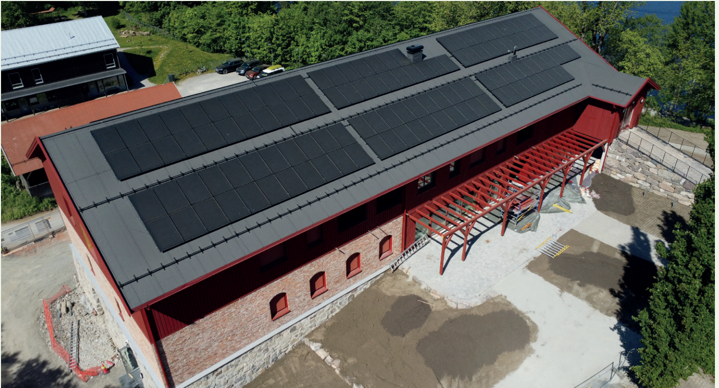
Solcellepanelene dekker hele taket til Nedre Sem Låve, som følge av at Statsforvalteren krever symmetri.
