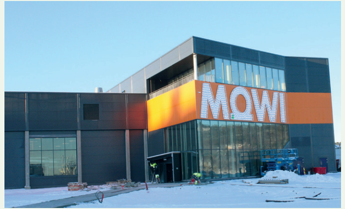
Det nye anlegget er bygget på Jøsnøy på Hitra.
