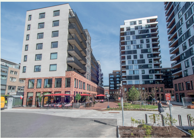
Med ferdigstilling av andre byggetrinn har kvartalet fått et flott og levende bygulv.
