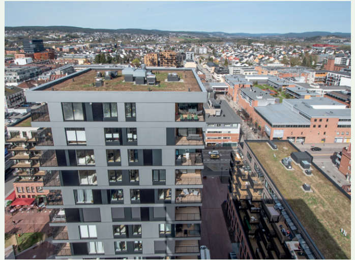
Byggene er beplantet med sedum på taket.
