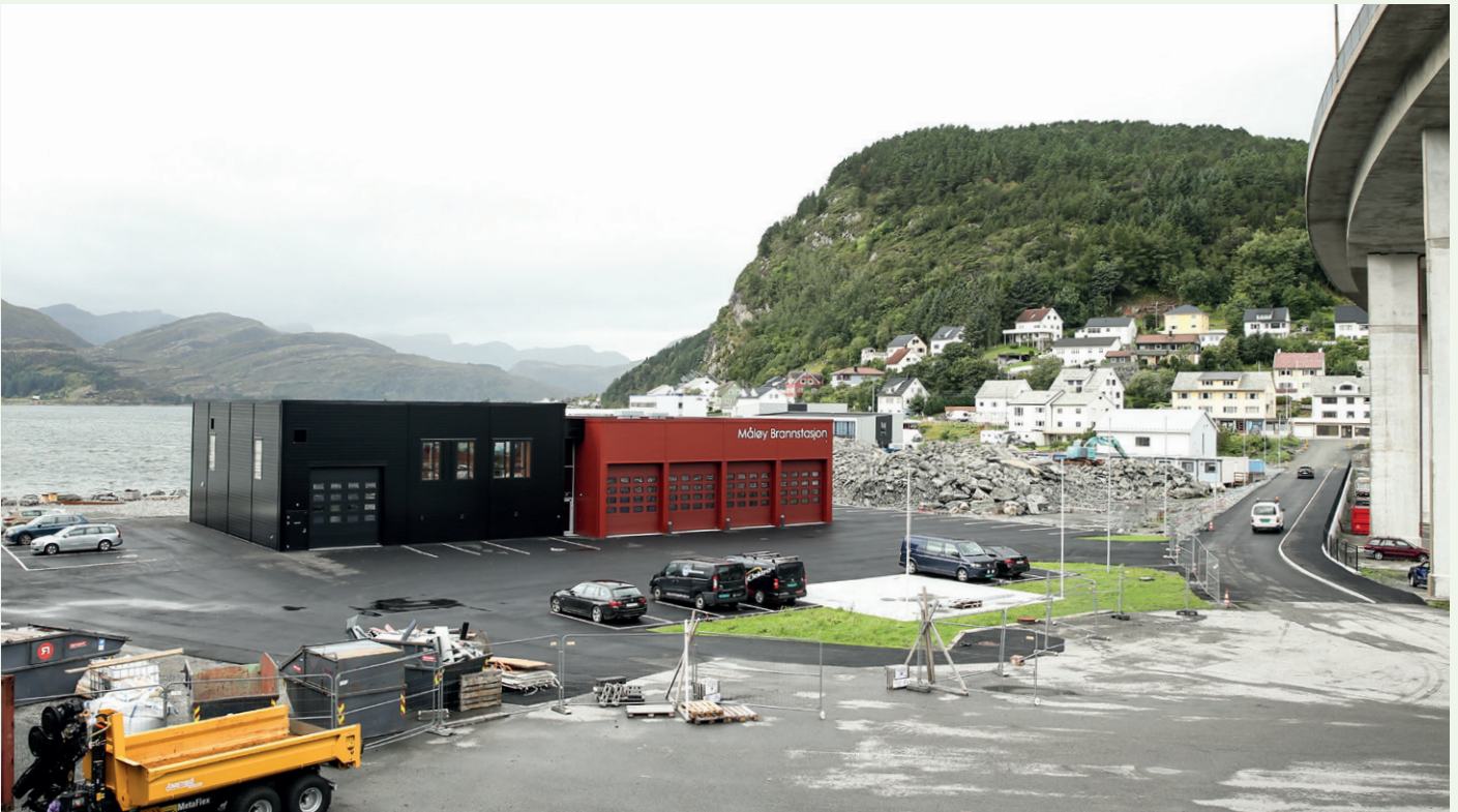
Her ser vi hvor nye Måløy brannstasjon ligger på Moldøen rett under Måløybrua. Måløy sentrum ligger til høyre uten-for billedkanten. Til høyre ved brofundamentene ser vi den nye veien med gang- og sykkelvei Veidekke har hatt som tillegg til jobben med å bygge brannstasjon.
