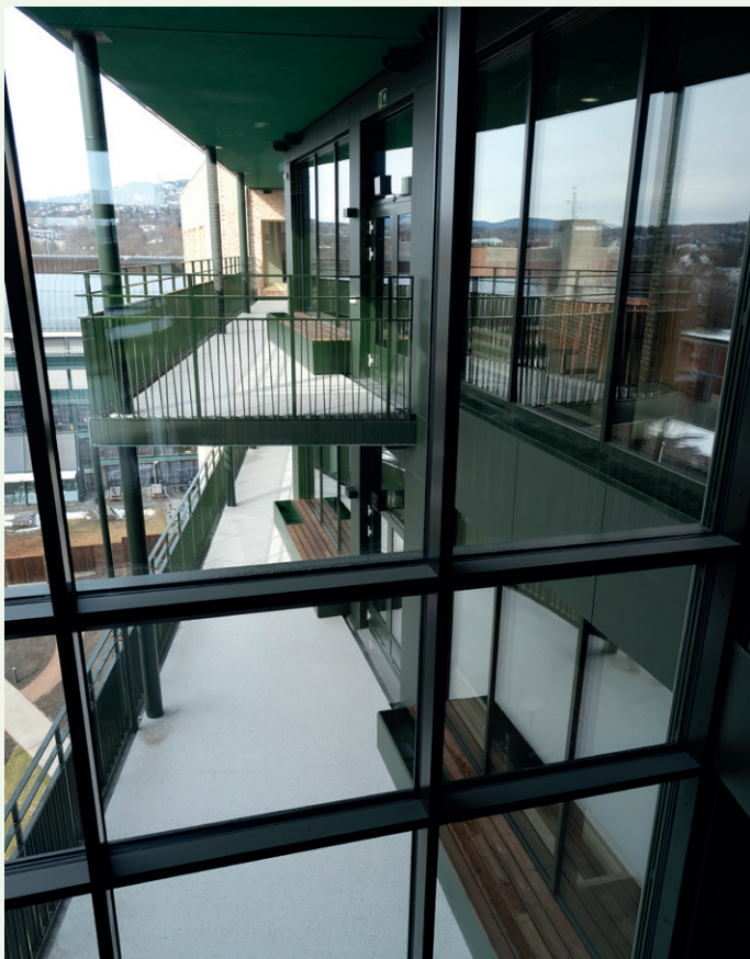
Det nye sykehjemmet har et areal på 15.900 kvadratmeter, fordelt på sju etasjer, kjeller og et takoppbygg.
