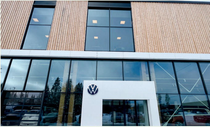
Inngangen til Volkswagens del av forhandlerbygget.
