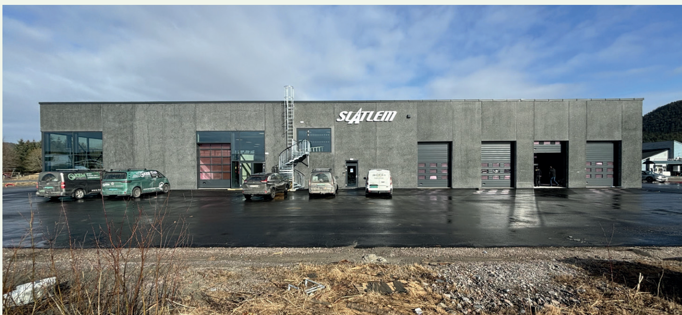
Baksiden av anlegget.
