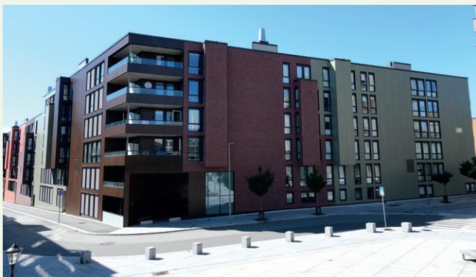
Alle leilighetene har egen balkong eller markterasse.
