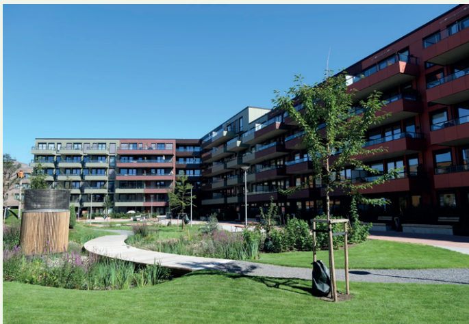
I Lumanders Hage har Veidekke bygd 214 boliger.
