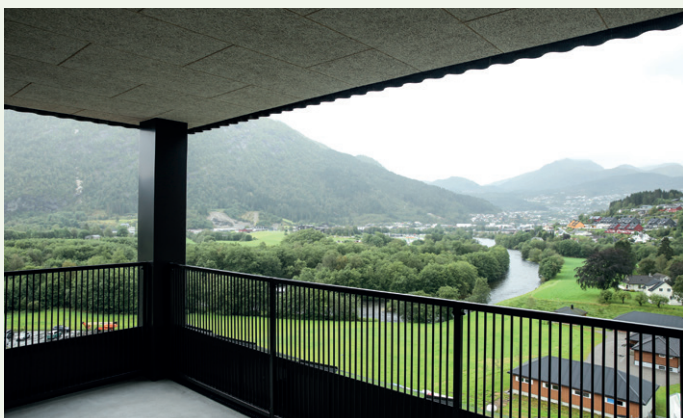
I hjørnene sørover i de fem øverste etasjene er det overbygget terrasse med utsikt mot Førde sentrum. Her er det trebetongplater i overbygget.
