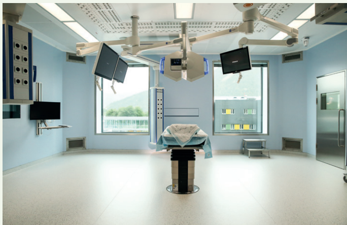
En av ti operasjonssaler i operasjonsområdet i 2. etasje. Her har byggherre Helse Førde ansvaret for oppbygging av rommene selv, blant annet er det spesialmateriale på vegger.
