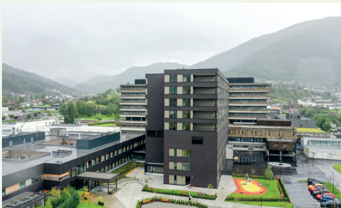
Livabygget har ni etasjer med totalt 13.500 kvadratmeter. Fasaden har vedlikeholdsvennlige Swisspearl sementfiberplater og aluminiumskledning.
