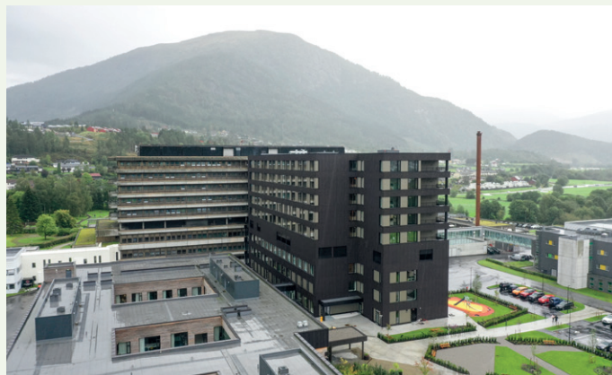
Livabygget sett fra nordvest. Nordic Office of Architecture står for arkitekturen.
