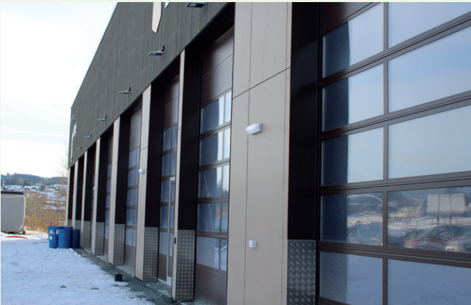
Kjøreportene har front mot veien utenfor og gir enkel utkjøring ved utrykning.
