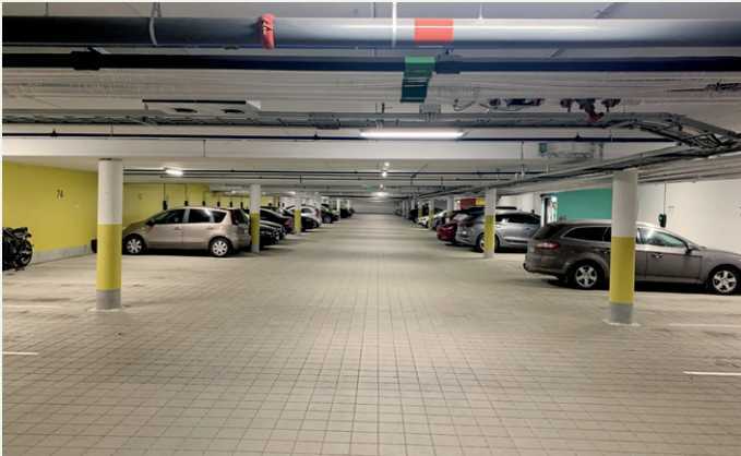
Parkeringskjelleren er 200 meter lang.
