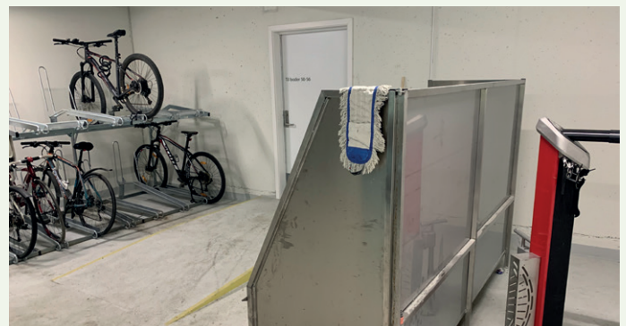
I tilknytning til p-kjelleren er det etablert sykkelparkering med muligheter for vask og reparasjon av sykler.
