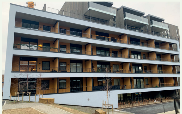
Blokkene K og L er på henholdsvis seks og syv etasjer, hvor man i tillegg har en og to underetasjer som rommer boliger og boder.
