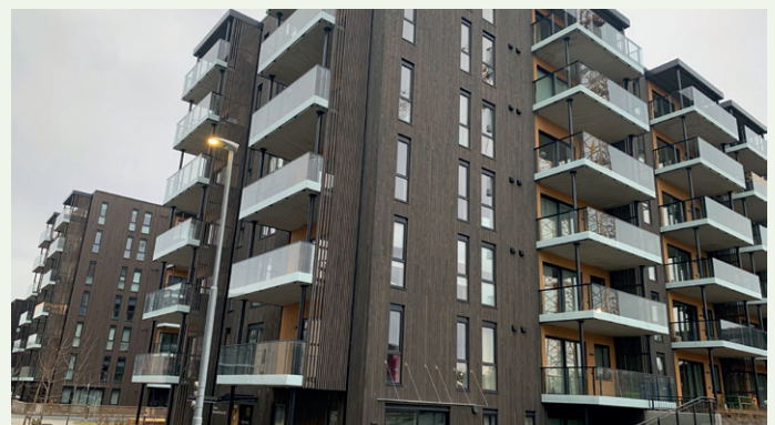
Byggene har fasade som øvrige bygg i kvartalet, med trekledning som er impregneret/farget og sto-puss, med innslag av platekledning.
