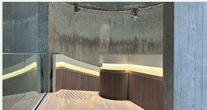
For mange i byggenæringen kan det bli like interessant å iakttas selve konstruksjonen og arbeidet som er gjort for å transformere en gammel kornsilo til et moderne museum. Foto: Backe/Stein Inge Jærnes
