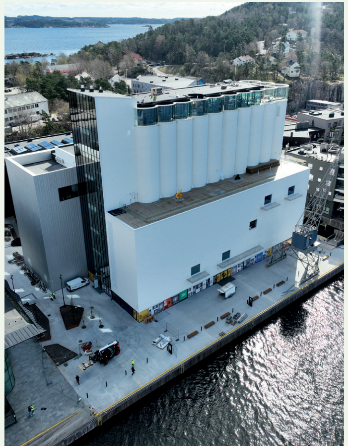
Ved siden av rehabiliteringen av eksisterende konstruksjon er det også bygget flere nye konstruksjoner og bygg. Foto: Backe/Håkon Rysstad
