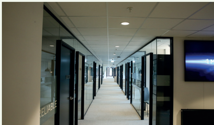
Fra et gangareal i kontorområdet. Her er teppeflis på gulv, systemhimling og systemvegger i glass og gips.
