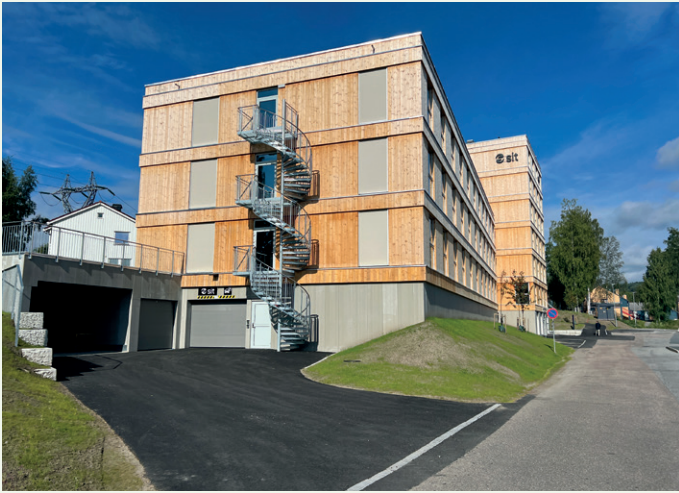
Byggets fasader er levert som elementer og er kledd med ubehandlet malmfuru.
