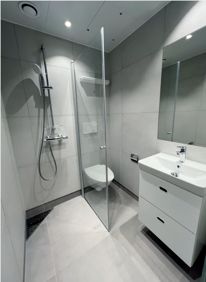
Studentleilighetene har egne bad som er levert som prefabrikkerte kabiner.
