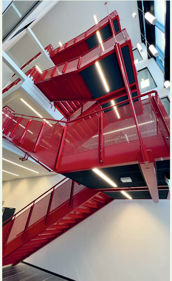
Det er bygget en iøynefallende trapp som forbinder etasjene.
