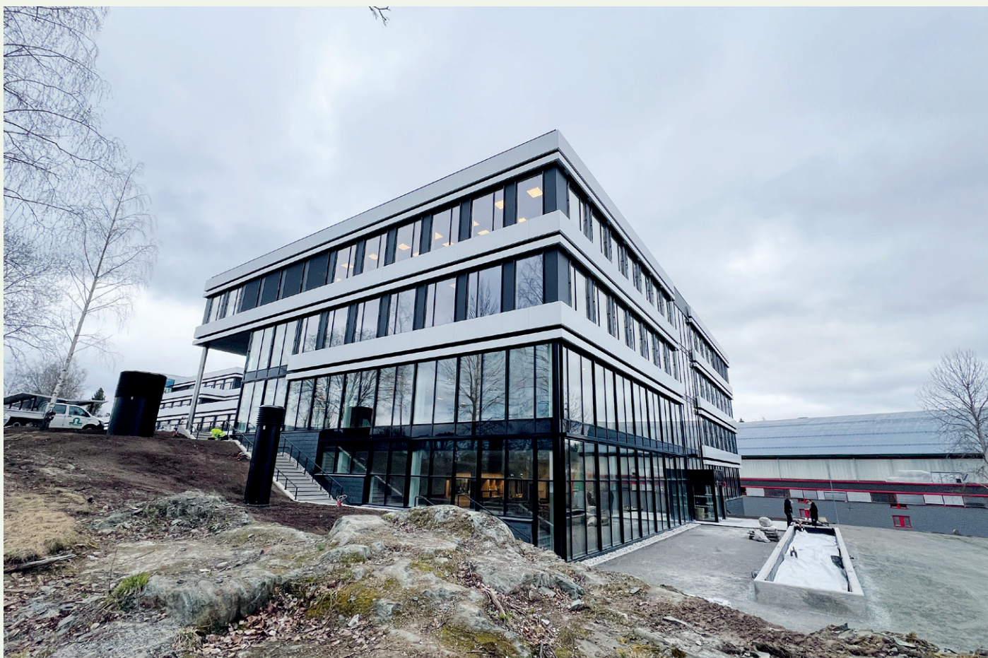
Bygget er satt opp på en skrående tomt, så underetasjen vil i praksis oppfattes som en førsteetasje.
