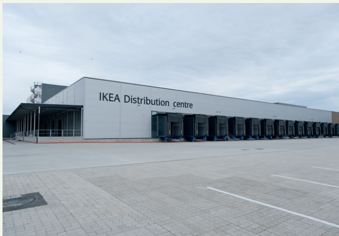
Hovedlageret til Ikea i Vestby har et bruttoareal på over 43.000 kvadratmeter.
