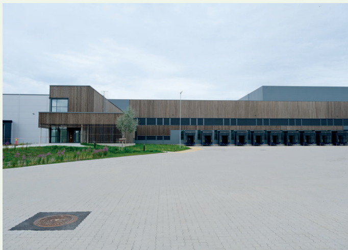
Mellom portene og lagerseksjonene er det et stort varetorg.
