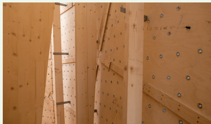
Klatretakene er skrudd direkte inn i bæreveggene av massivtre.
