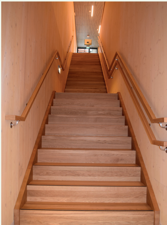
Trappeløp sett nedenfra fra 1. etasje.
