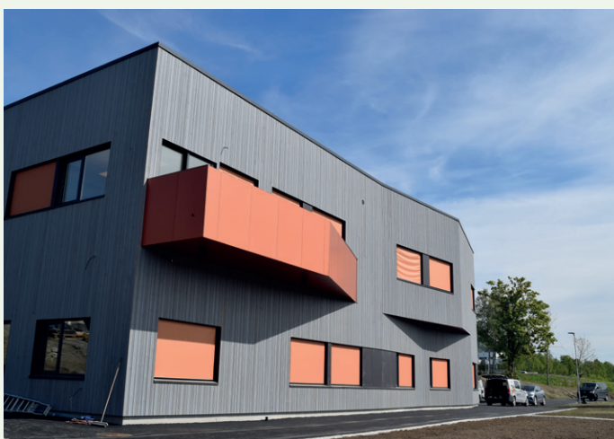
Fasade mot sør sett fra vest mot øst.
