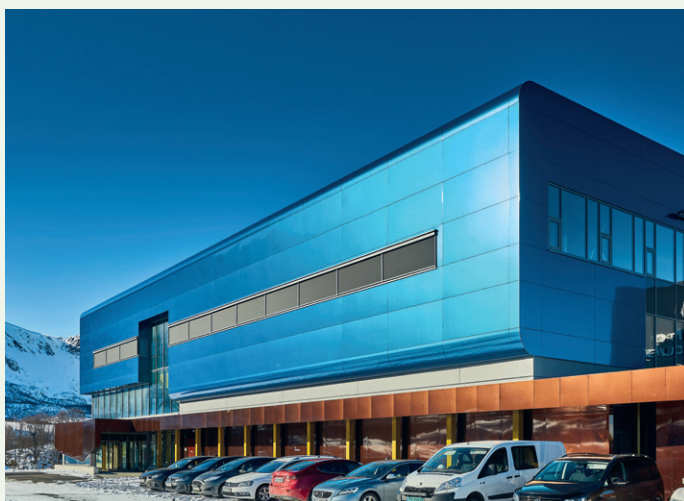
Bygget er kledd med alucobond fasadeplater i ulike farger.
