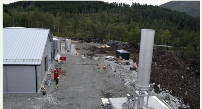
Flammertårn og deler av prosessbygget.
