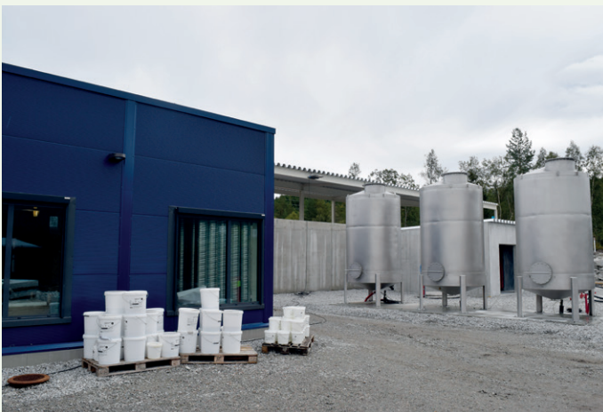
Kontrollrom, kontor og pauserom for plass i det blå bygget.
