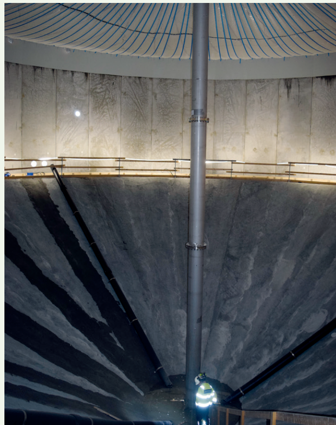
Inne i prosesstanken som stikker 7,5 meter ned i grunnen.
