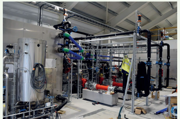
Prosessanlegget er under sluttmontering.
