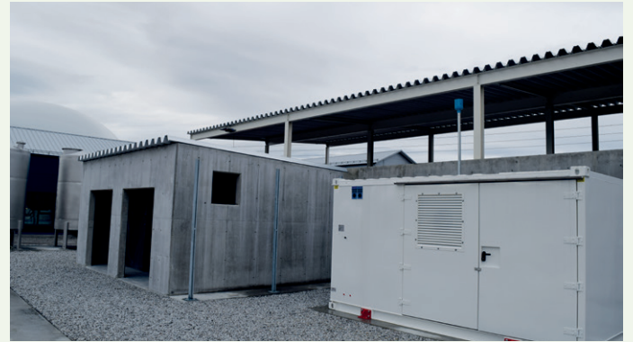
Kompressorhus med lasteområde for uttransport av gass i bakkant.
