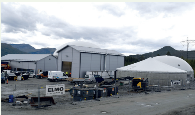
Biogassanlegget sett fra nordøst.
