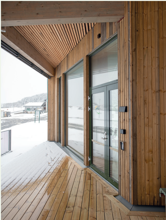
Utkraging over første etasje.
