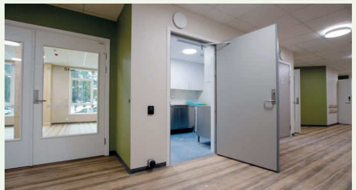
En knapp man kan sparke borti åpner dørene på skyllerommet.
