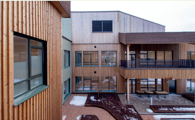
Fasadene er en blanding av Thermowood og fasadeplater.
