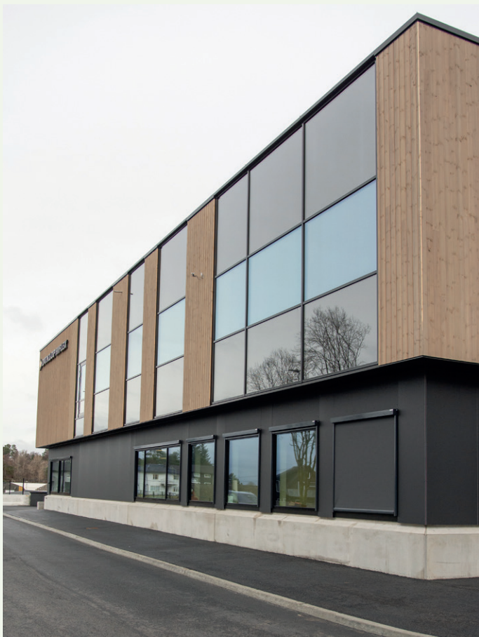
Innkjøring til byggetrinn 1 i Godvik Næringspark.
