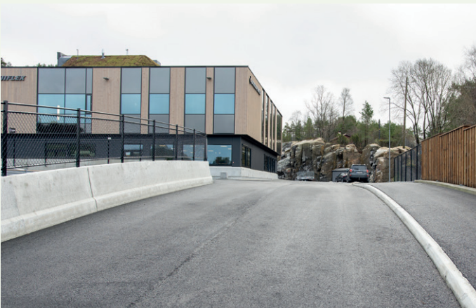
Innkjøring til byggetrinn 1 i Godvik Næringspark.
