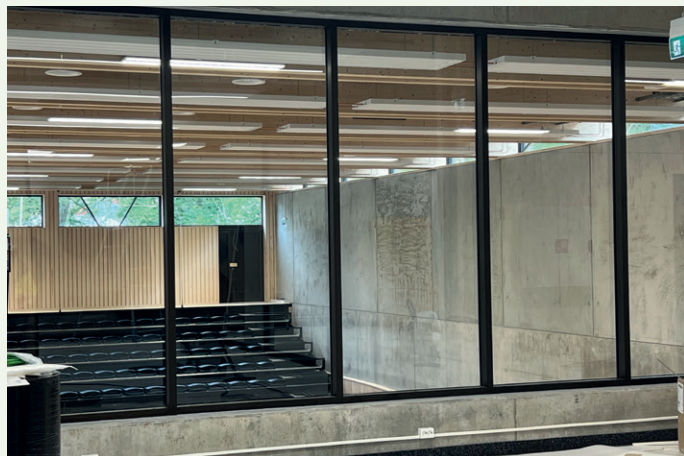
Legg merke til limtredragerne. De er uten spor av fukt, selv om de ble montert i en nedbørsrik periode.
