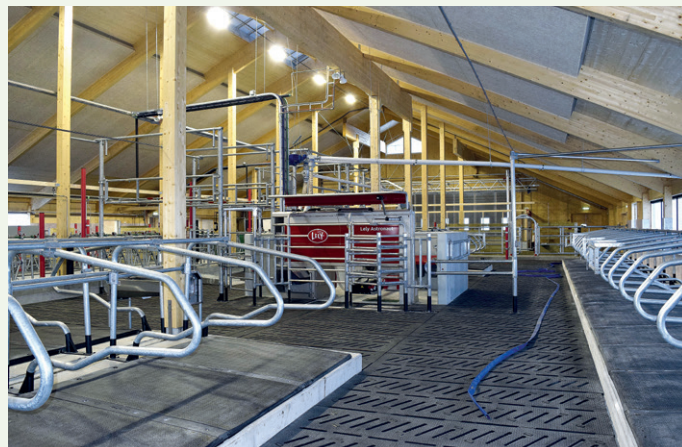
Fjøsinteriør med gummimatter i båser og på gangareal for dyr og lyd demping i tak.
