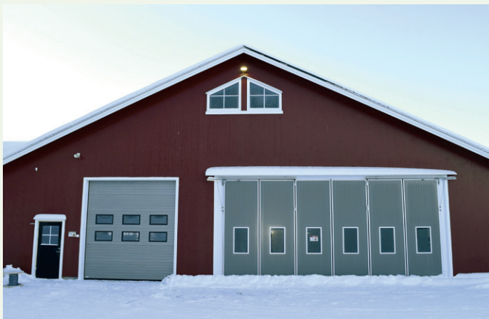
Fasade mot vest. Gjennom de store portene kan føret kjøres rett inn i lagerbåsene.
