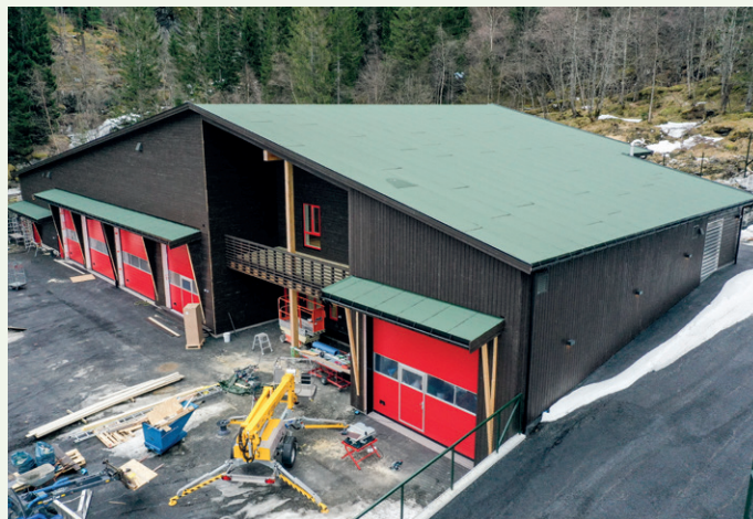
På utsiden av bygget er værbestandig malt fasadeledning fra Moelven Wood.
