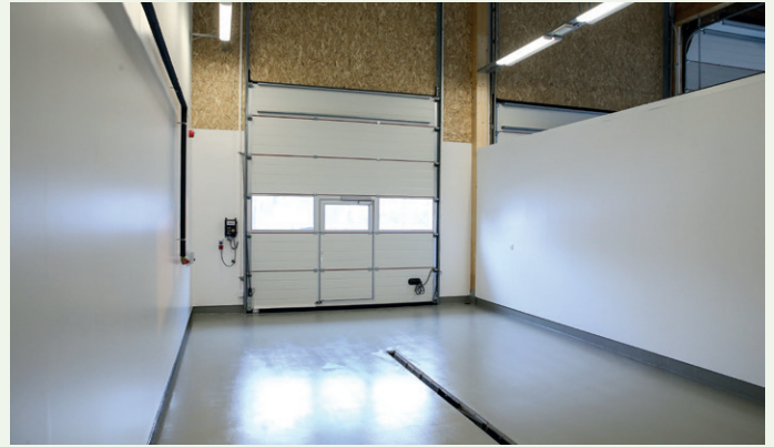
Denne vognhallen som er adskilt fra brann delen, er til ambulanse.
