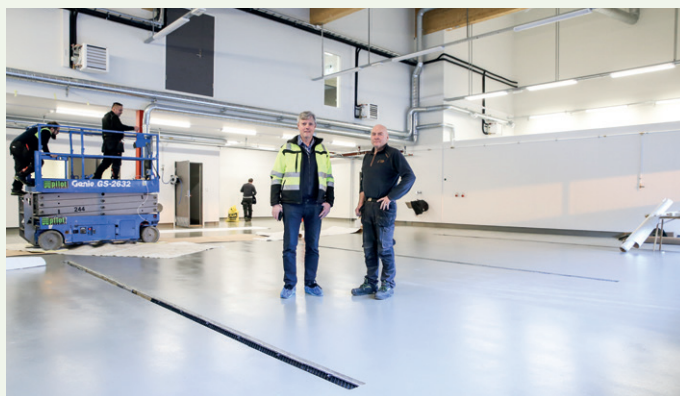
Inge Hole (t.v.) har vært prosjektleder og byggeleder for byggherre Stranda kommune, mens Geir Frøysa har vært byggeleder for hovedentreprenør HT Bygg Hellesylt. Her er de to i vognhallen der brannbilene skal stå.
