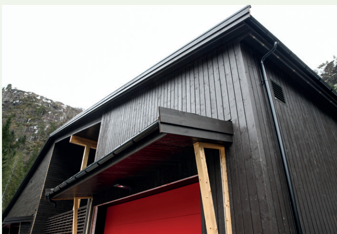
Det er lagt vekt på å bygge klimavennlig i verdensarvområdet. Mye av byggematerialet er i tre.
