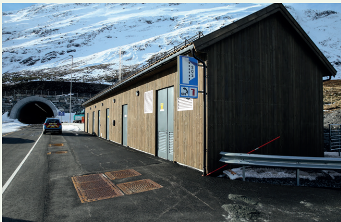
Det er til sammen seks slike tekniske bygg, et på hver side av tunnelen og fire inne i tunnelen. Dette er teknisk bygg på Indreeide.
