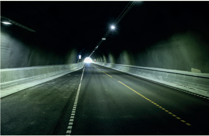
Inne i tunnelen i retning Indreeide. Betongføringskantene er bygget av Sirdal Betong. Tunnelen er bygget med T8,5-profil. Det vil si at det er 8,5 meter mellom betongføringskantene, noe som gir kjørebane på 3,25 meter mellom gul- og hvit stripe.
