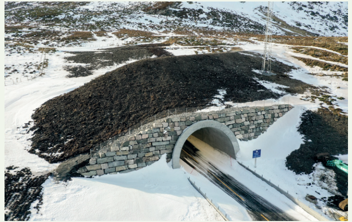
Det er bygget en rasvoll på 135 meter over tunnelportalen på Indreeide. Antennen på toppen er med og gir mobildekning i området, noe som også er et resultat av prosjektet.
