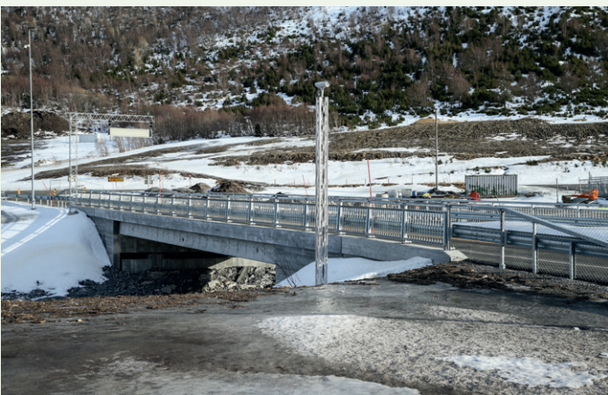
Brua på 25 meter er bygget i forbindelse med prosjektet og inngår i prosjektkostnaden på 1,05 milliarder kroner inkludert moms.
