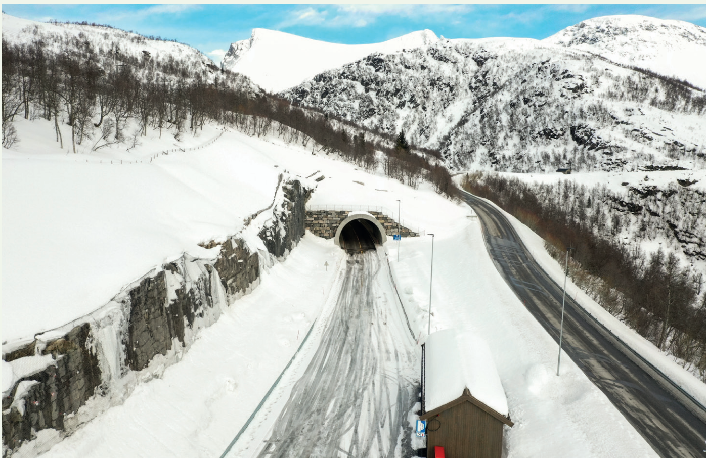
Tunnelportalen på Korsmyra med eksisterende fv 63 til høyre. Tunnelen fjerner 13 rasutsatte områder i dalføret vi ser midt i bildet, men blir trolig brukt i hovedsak om vinteren siden veien på utsiden er en turistrute.
