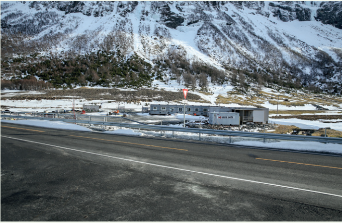
Brakkeriggen er plassert ved inngangen til anleggsområdet på Indreeide, i krysset mellom eksisterende og ny fv 63.
