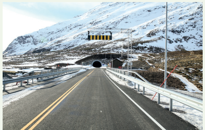
Det er bygget om lag 200 meter ny vei på begge sider av tunnelen. Her fra innkjøringen på Indreeide i Fjord kommune når du kommer fra Eidsdal i retning Geiranger.
