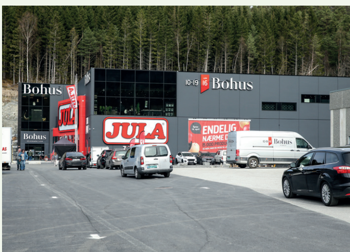
Holvik Glas i Førde har levert glassfasaden som møter deg i inngangspartiet.
