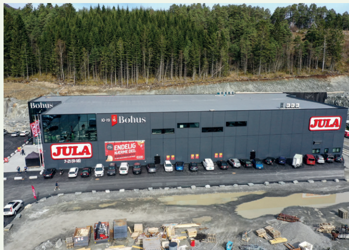
Nybygget er 13 meter høyt og 100 meter langt. Det er bygget av betongelementer fra Elementpartner på Åndalsnes. Vareleveransene skjer på høyre side av bygget der det er lagerområder innenfor.
