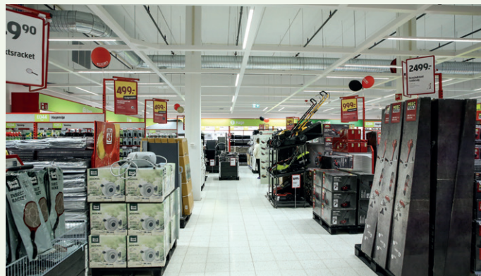
Innvendig i Jula-butikken er det terrazzofliser på gulv og tegohimling - lyshimling - under eksponert betong i tak.
