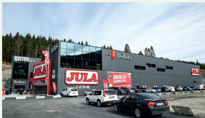
Glassfasade fra Holvik Glas og malte, eksponerte betongelementer er materialene på fasaden.
