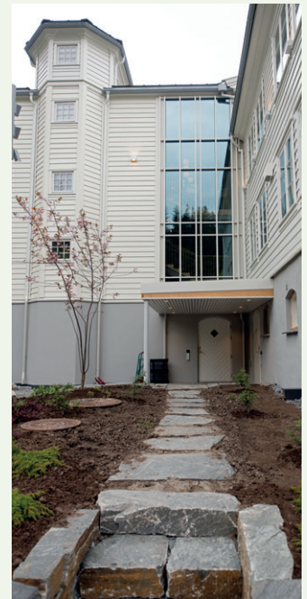
Opparbeidet uteområde og glassfasade i hovedtrapp.
