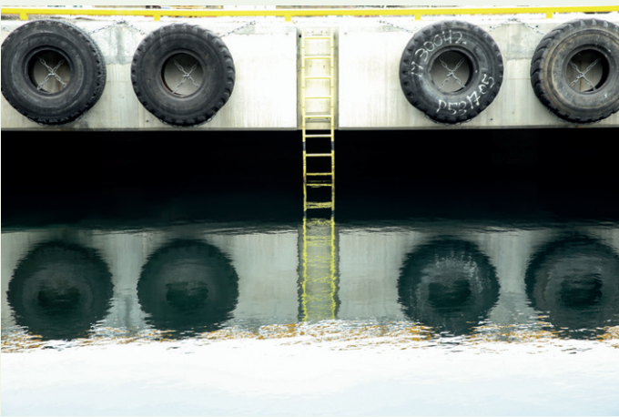
Betongdekket er elementer fra Finnøy Betong som er lagt på stedstøpte dragere som igjen ligger på stålpeiler festet i havbunnen. Brukte hjullasterdekk er fendere langs hele kaia.
