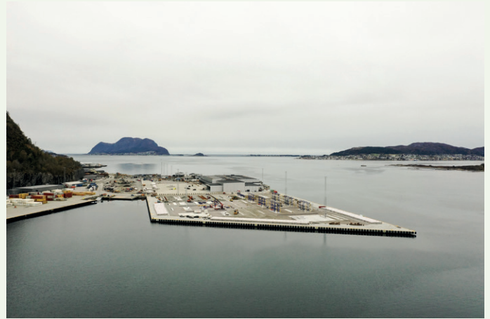
Nye Flatholmen Havneanlegg sett i droneperspektiv fra øst med Godøy, Giske og Valderøy i bakgrunnen.
