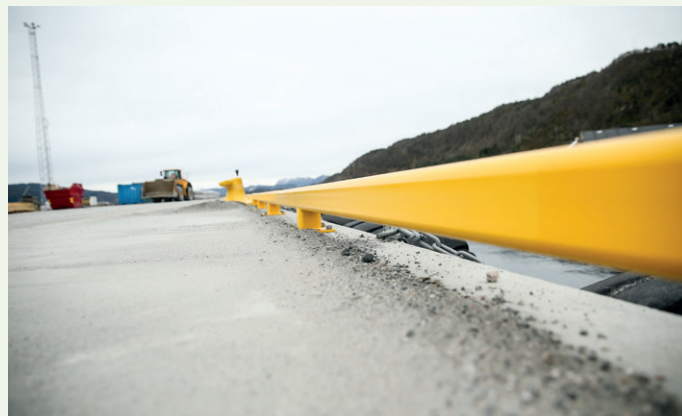
Selve kaia er 15 meter bred og går 725 meter rundt halvøya som er fylt i fjorden. Betongdekket er elementer fra Finnøy Betong.
