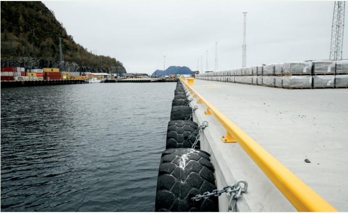
Kaia sett fra spissen i sørøst inn mot land. Pallene til høyre er fylt med belegningsstein som skal legges inne på kaiområdet.
