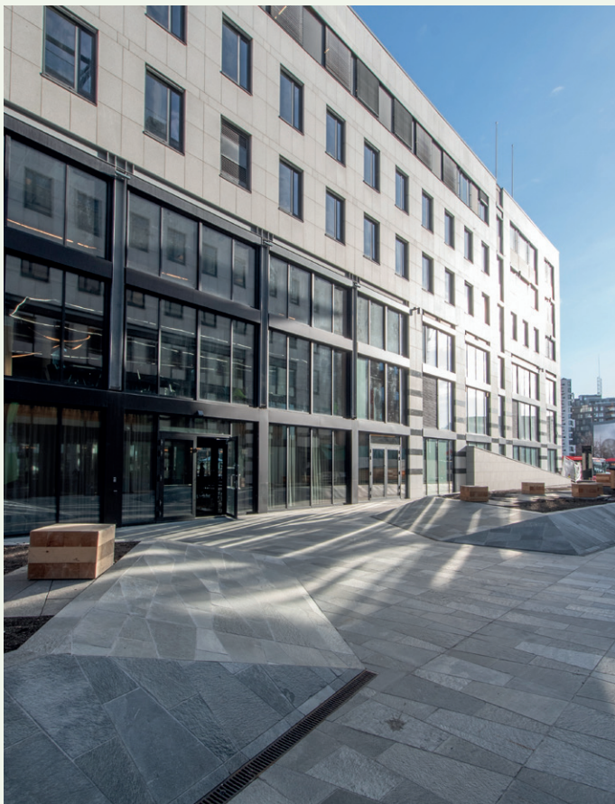
En av de store grepene som er gjort i rehabiliteringen, er å fjerne en felles førsteetasje med nabobygget og etablere en åpen byggate mellom byggene.
