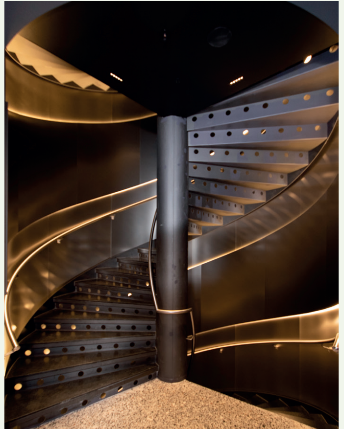
Vindeltrappen kombinerer gjenbruk av en gammel trappekonstruksjon med ny stålkledding.
