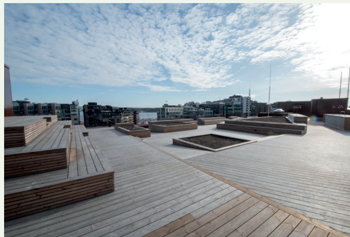
Hele 800 kvadratmeter takterrasse blir tilgjengelig for brukerne av bygget.
