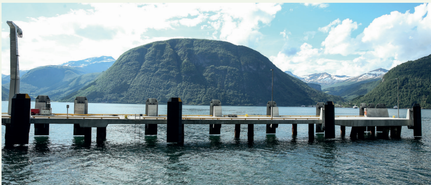
Pelene på Linge ferjekai er fullprofil pelar boret to meter ned i fjellet fra lekter. Ytterst er det 35 meter dypt ned til sjøbunnen. Med skrått fjell var det på grensen av hva som var mulig å bygge.
