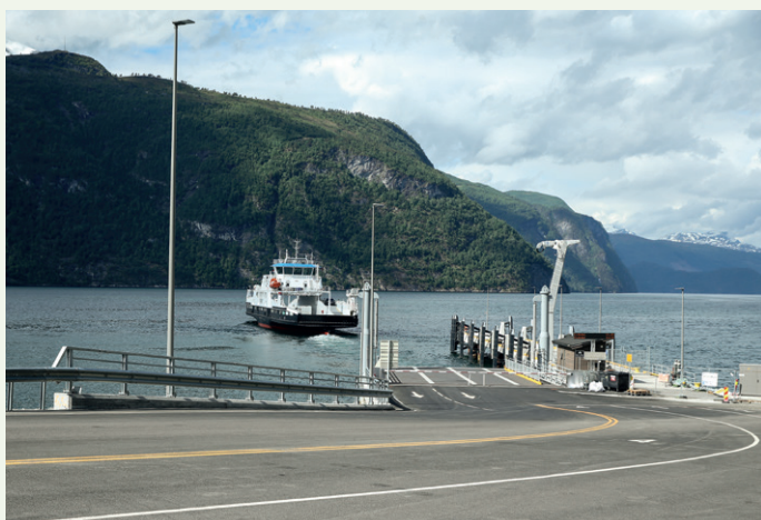
MF «Sunnylvsfjord» på vei mot nye Linge ferjekai. Området med oppstillingsplasser er fylt og støpt slik at det står på en halvbro.
