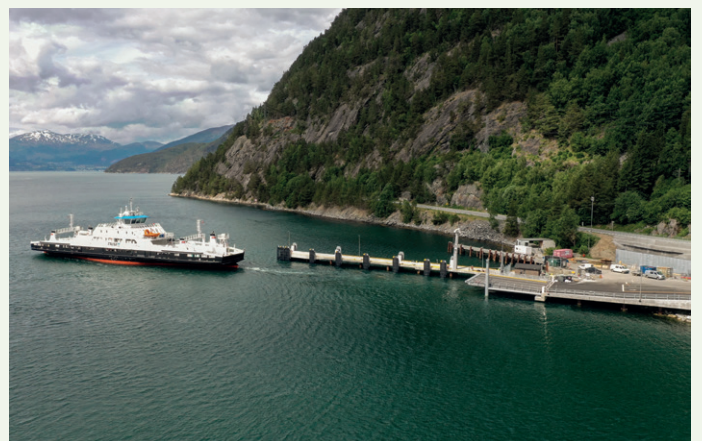
Den nye ferjekaia på Linge med nye MF «Sunnlyvsfjord» som legger fra. Til høyre ser vi hvordan kaia er forlenget til biloppstillingsområdet.
