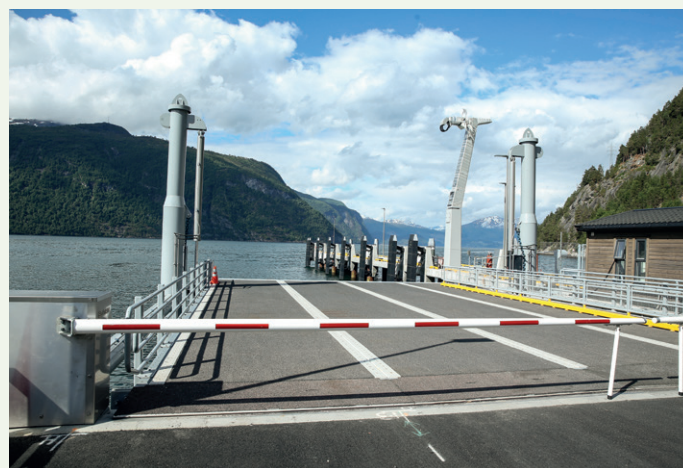
Kjørerbrua i stål på Linge ferjekai er 12 x 18 meter. Kaipiren er 75 meter lang og sju meter bred. Ladetårnet til høyre.
