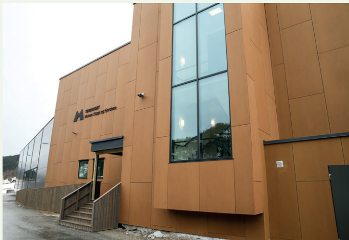
På inngangspartiet er det Rockpanel fasadeplater og glassfasade fra Holvik Glas.
