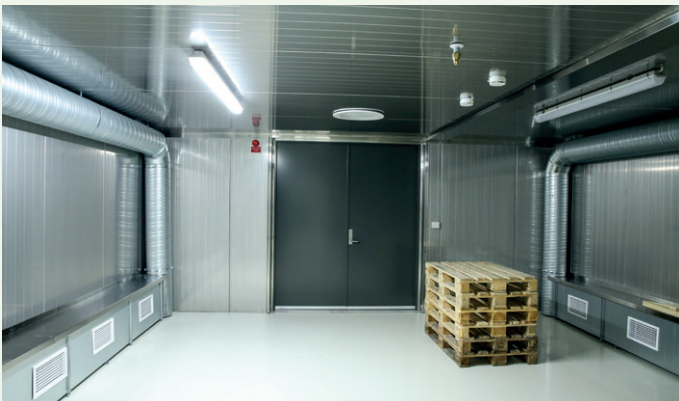
I dette rommet blir gjenstandene som kommer inn varmebehandlet til en kjernetemperatur på 55 grader. Alt av dyr og insekter må bort før lagring.
