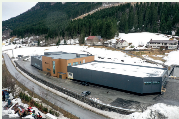
Fellesmagasinet sett fra sørøst. Fasaden er kledd med Ruukki sandwich-panelet på begge sider av inngangspartiet.
